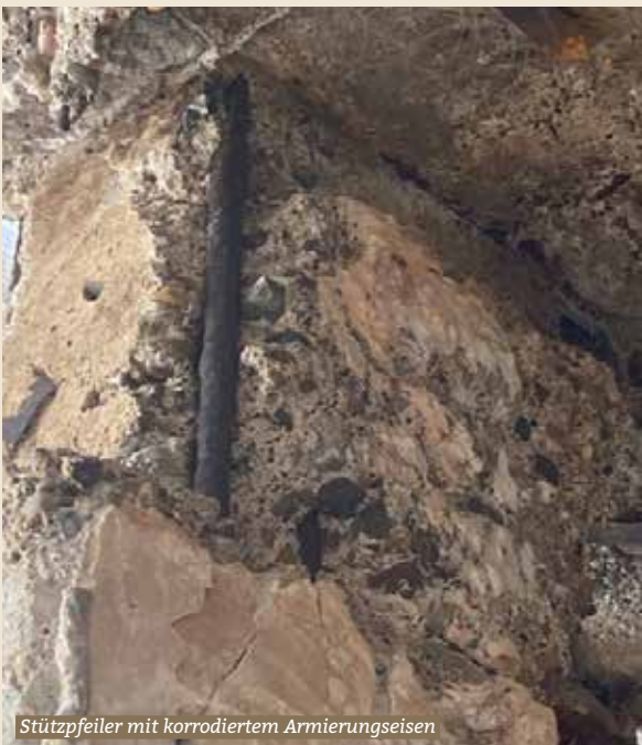
Decke über dem Nichtschwimmerbecken mit korrodierten Armierungseisen
