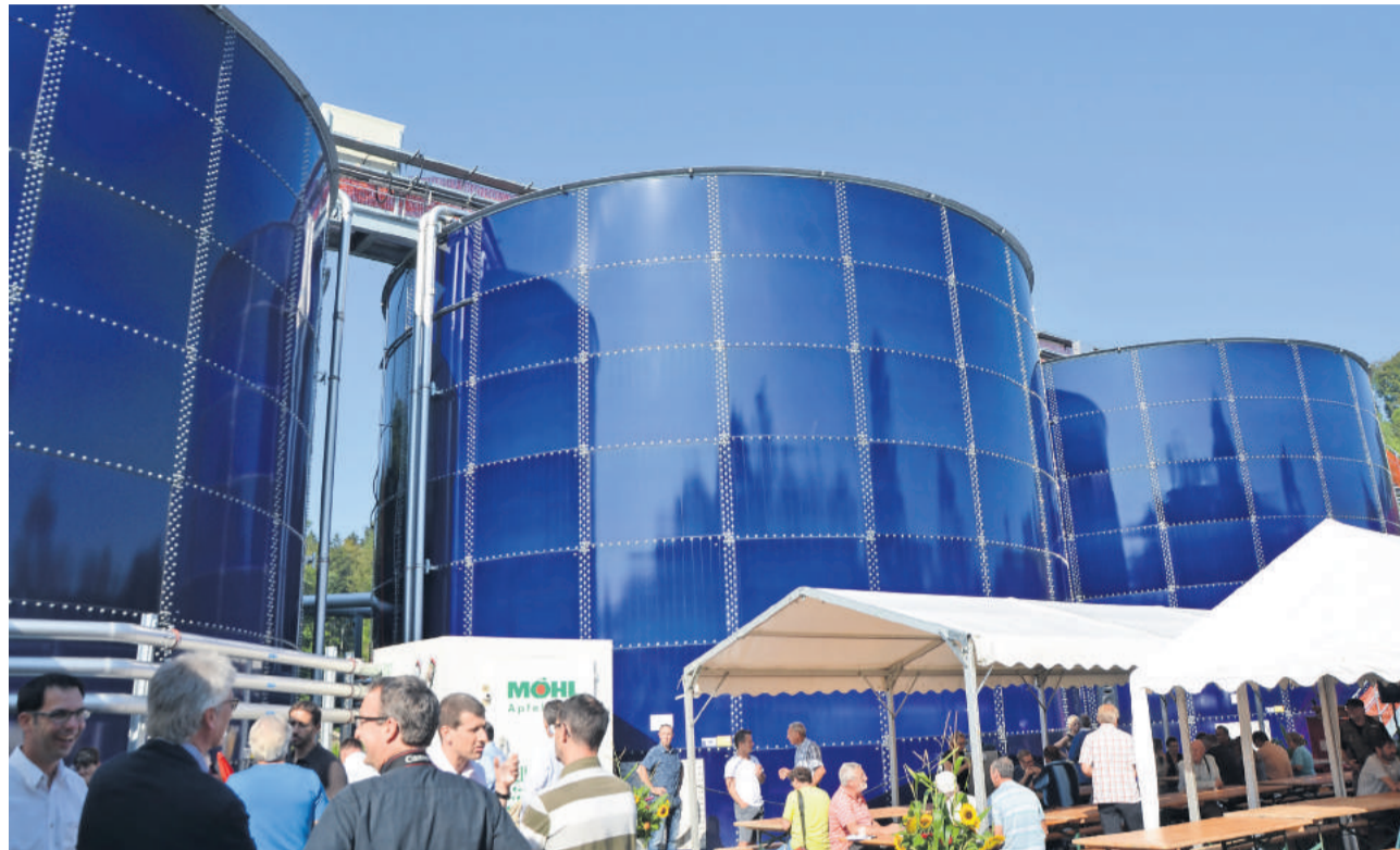
Das neue Wahrzeichen: drei leuchtend blaue Kessel
