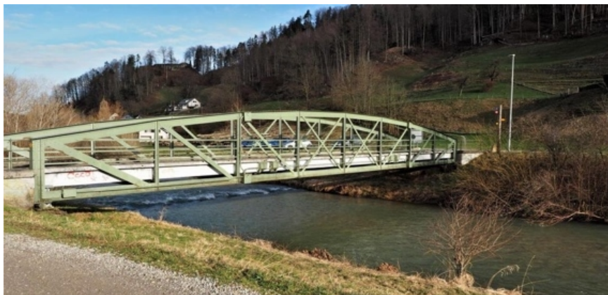
Halbparabelträgerbrücke Hundschilen (Sennhüttenstrasse)
